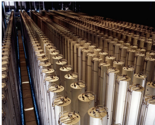
Image:Gas centrifuge cascade.jpg
